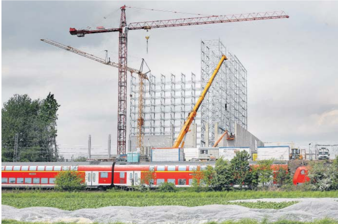
Imposant: Das in Nähe der Bahnlinie Bielefeld – Hannover gelegene Hochregallager von Wellteam in Diebrock von der Bielefelder Straße aus gesehen. 35 Meter ist das Objekt hoch, dass im Herbst fertiggestellt sein soll.
