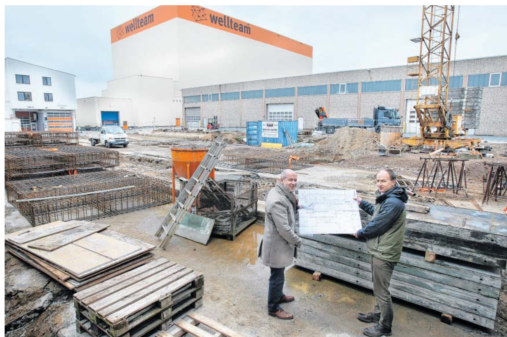
Baustelle: Wellteam-Geschäftsführer Sieghard Schöneberg und der Technische Leiter und Geschäftsführer von Well-Service, Peter Richert, machen sich vor Ort ein Bild vom Fortgang der Bauarbeiten an der Zeppelinstraße. Im Hintergrund das Hochregallager, das vor drei Jahren in Betrieb genommen wurde.
