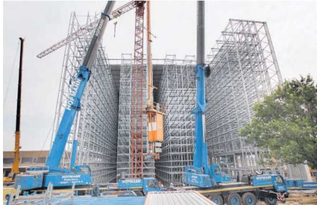
Starke Arme: 17 Tonnen wiegt ein Bauteil der Regalbediengeräte in Schöneberg-Orange, die an Ort und Stelle in der Regalgasse montiert werden. Mehrere Autokräne kamen zum Einsatz.
