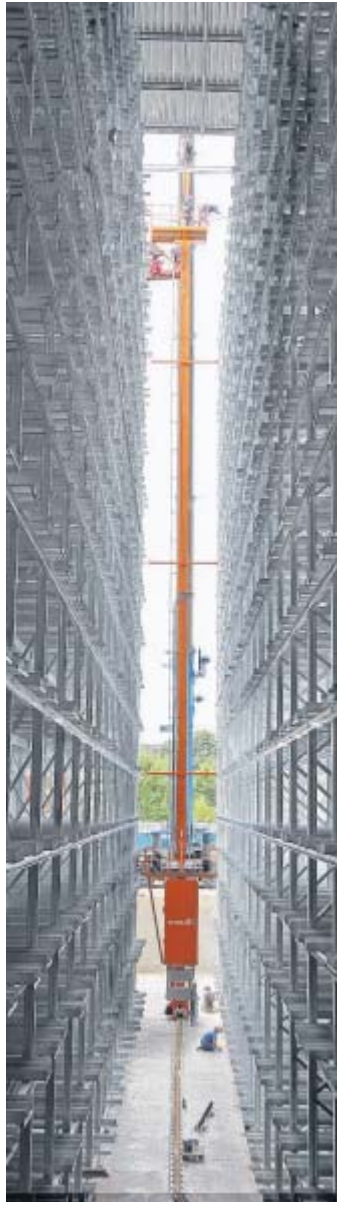
37 Meter lang: Das Fundament liegt unter Geländehöhe.
