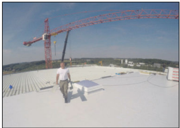
Dem Himmel ganz nah: Auf dem Dach – in 35 Metern Höhe – werden die einzelnen Elemente per Hand verschraubt.
