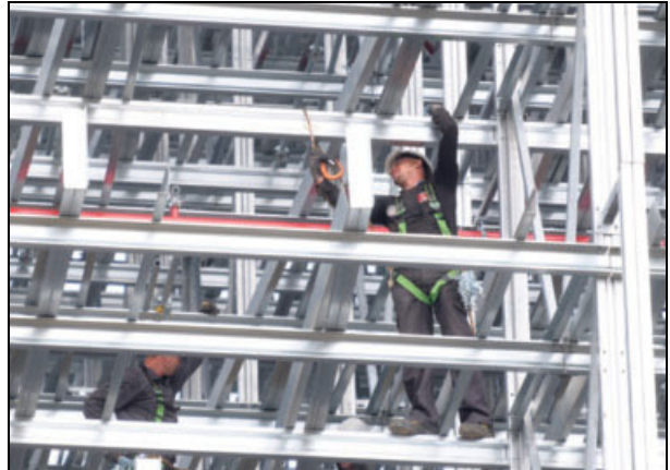
Kein Job für Angsthassen: Die Arbeiter hangeln sich durch die verschiedenen Ebenen. Gesichert sind sie – ähnlich wie Bergkletterer – mit Seilen.
